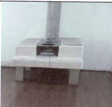
Foto 16: Sustitución de estufa rural (completa) incluye chimenea y plancha de metal. Instalación de azulejo en estufa rural.
