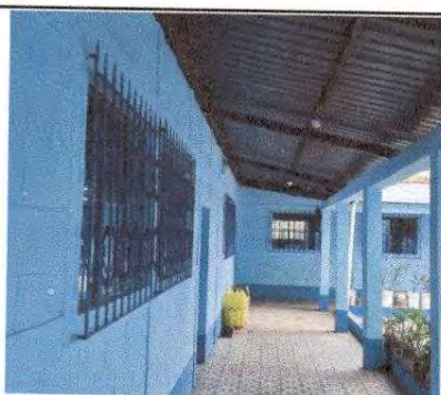
Foto 5: Mantenimiento a balcones de metal.
