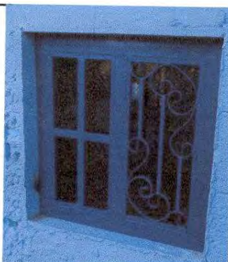
Foto 3: Sustitución de ventanas de madera por metal mas vidrio.
