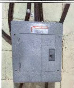
Foto 14: Sustitución de talbero de flipones.
