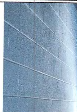
Foto 8: Pintura en muros interiores.
