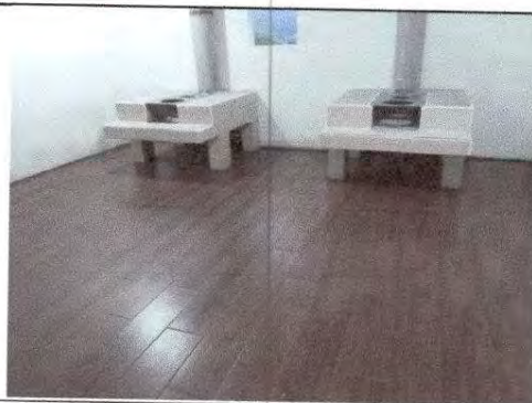
Foto 6: Sustitución de piso ceramico.
