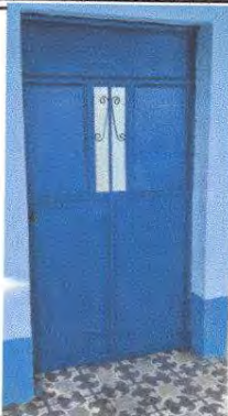
Foto 1: Mantenimiento a estructura (lijado, cambio de tubo, cepillado, sujecioens, aplicacián de pintura).
