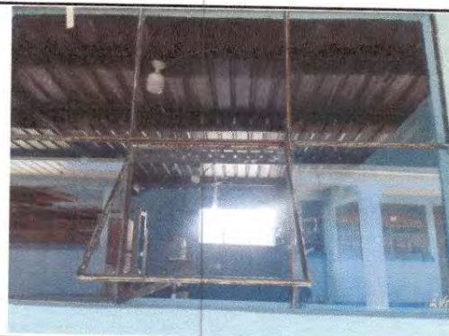
Foto 4: Sustitución de vidrios.
