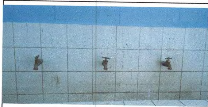
Foto 12: Sustrucción de llave de chorro.
