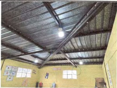
Foto 13: Sustitución de focos ahorradores.
